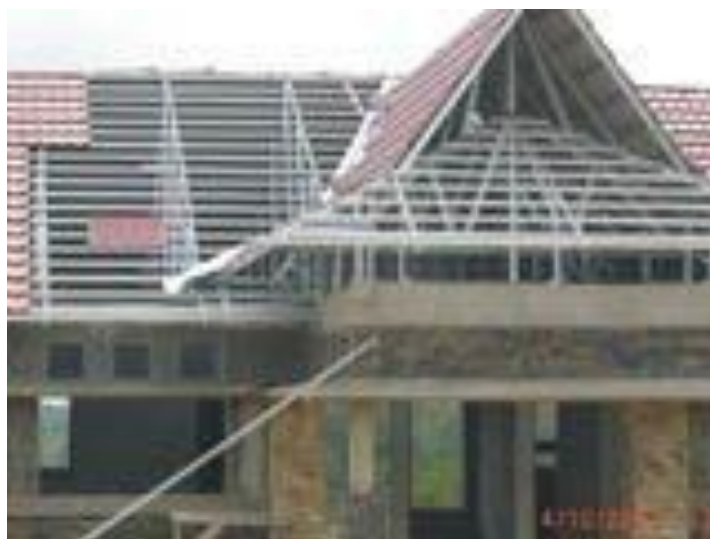
Gambar 4.8. Rangka Atap Kombinasi
