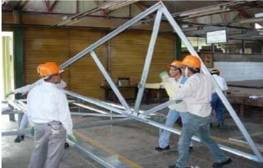
Gambar 4.13. Pengangkat kuda-kuda secara manual
