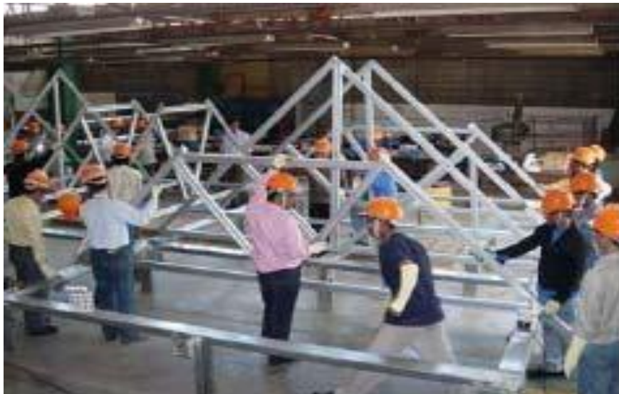
Gambar 4.14. Pemasangan kuda-kuda di atas ring balok
