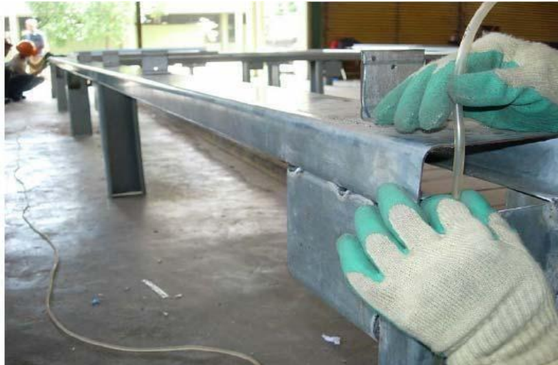
Gambar 4.11. Kontrol siku dan leveling ring balok
