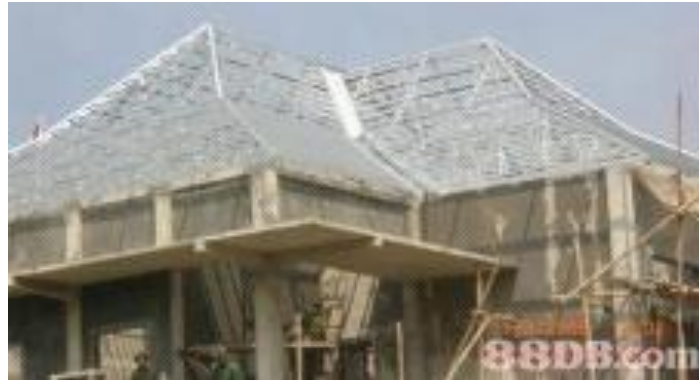
Gambar 4.6. Rangka Atap Perisai
