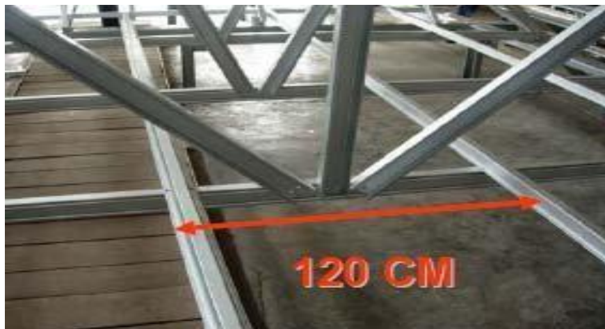
Gambar 4.22. Pemasangan ceiling battens
