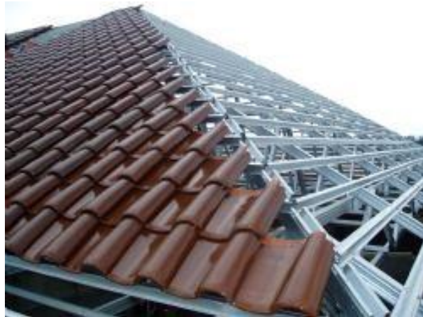
Gambar 4.30. Komponen reng yang sebagian telah dipasang genteng ( http://www.edselmax.com/rangka-atap-baja-ringan.html# )
