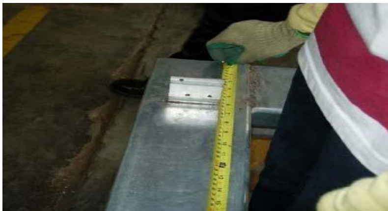
Gambar 4.12. Pemberian tanda posisi perletakan kuda-kuda dan pengukuran jarak antar kuda- kuda
