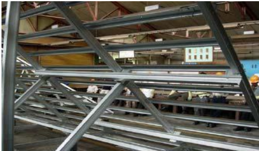
Gambar 4.20. Pemasangan outrigger overhang pada kuda-kuda pelana terakhir
