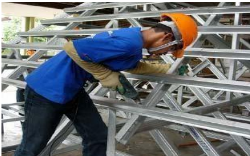
Gambar 4.19. Pemasangan screw pada reng ( Roof Battens )
