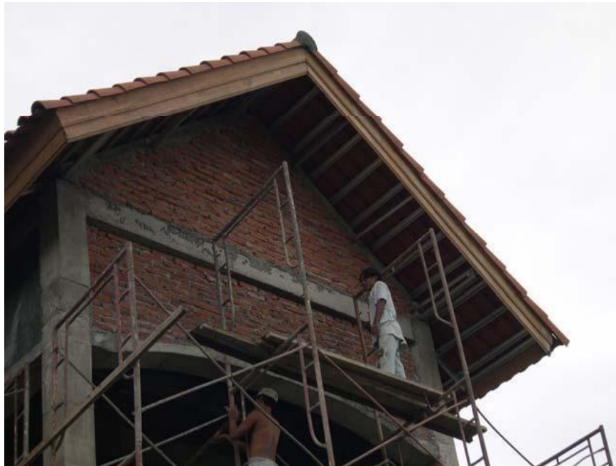
Gambar 4.21. Contoh hasil pemasangan outrigger dengan sistem overhang
