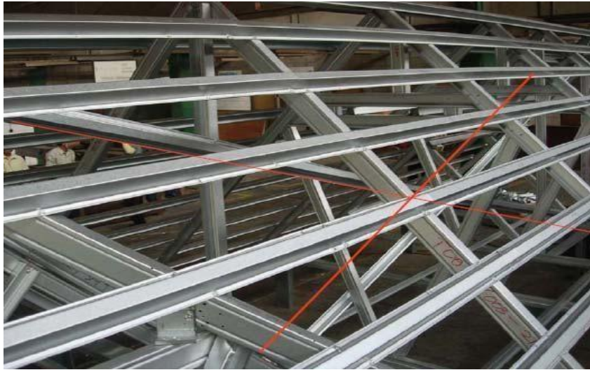
Gambar 4.18. Pemasangan bracing/ pengikat
