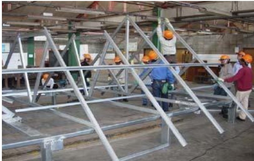
Gambar 4.17. Kontrol ketinggian kuda-kuda (Apex)
